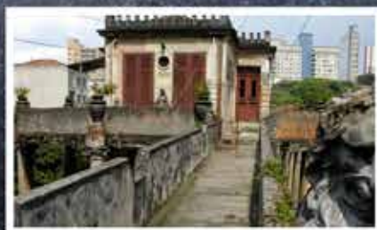
DOCUMENTÁRIO Vila Itororó Canteiro Aberto
